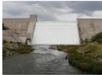
De Hoop Dam 15km away
